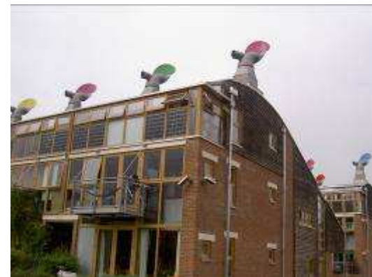
Fig. 3. 1 – Vivienda de consumo cero en UK, Bedzed
