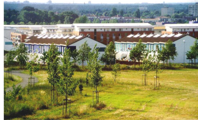
Fig. 3. 24 – Hileras de viviendas Passivhaus en Hannover-Kronsberg rows (en primer plano). La geometría de los edificios es similar a la propuesta Passivhaus francesa. Nótese que la apariencia visual de los edificios puede adaptarse fácilmente a las preferencias locales.
