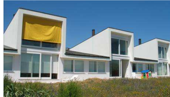
Fig. 3. 13 – Imagen de casa de baja energía existente en Portugal (Janas House)
